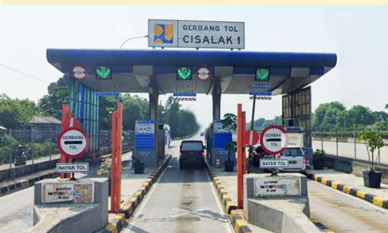
PINTU TOL CISALAK 1
